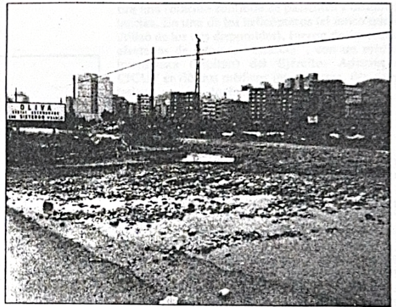
Desapareció literalmente el pavimento en la entrada a Oliva y el agua arrastró hasta allí numerosos enseres de las casas que resultaron inundadas. Recién en las primeras horas de la tarde del miércoles, las máquinas municipales pudieron iniciar sus trabajos de limpieza despejando principalmente las calles más céntricas y los accesos al edificio del Ayuntamiento.
