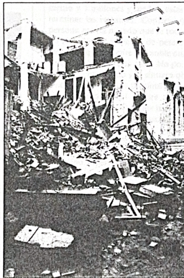
Además de la antigüedad, las causas principales de este derrumbe están en la acumulación de agua en una excavación realizada en la esquina, por parte de los técnicos de Arqueología del Ayuntamiento, ya que allí se habían encontrado restos de materiales de la llamada «época ibérica» y que eran estudiados en las últimas semanas.
